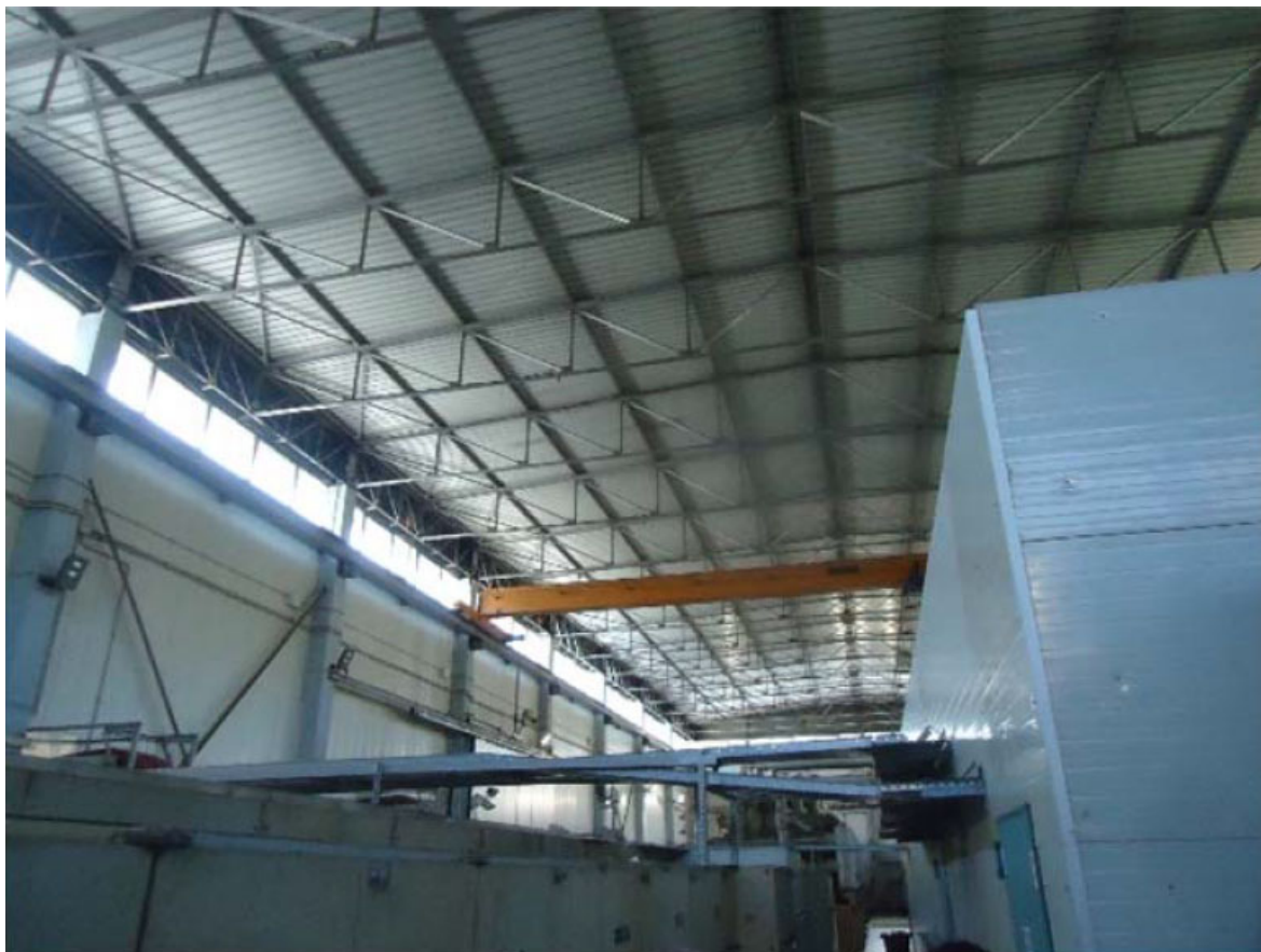
Figura 2 – Struttura capannone industriale.
